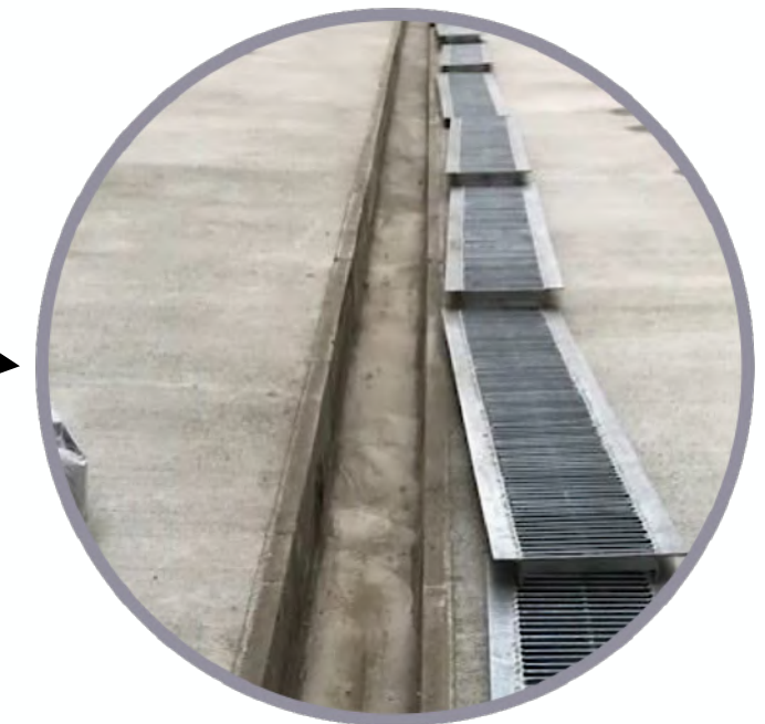
・ グレーチング清掃
